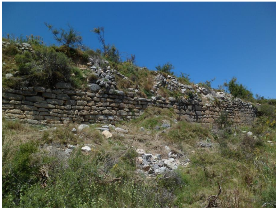
Fig. 6. Pseudo quadratum section of the wall of the Passet de Segària fortification (photo by F. Sala).
