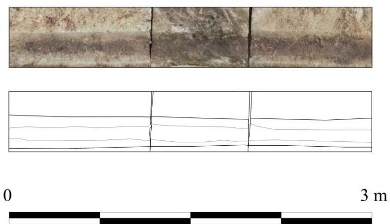
Fig. 20. Foto di USM 3, ascrivibile al Tipo tecnica 3. Elaborazione: M. Fronteddu.
